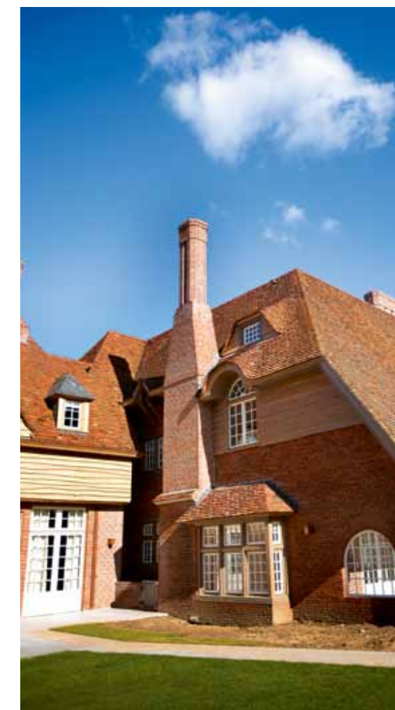
Het oorspronkelijk deel van het landhuis (rechts) met links de nieuwe aanbouw
